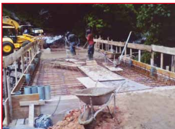
Lavori per la costruzione del ponte
