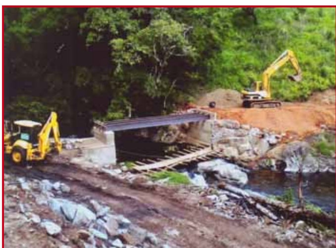
Ponte sul fiume Yovi
