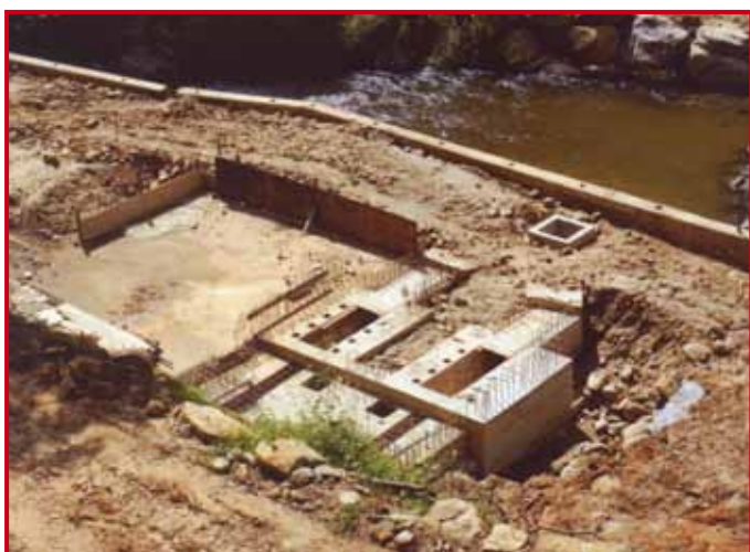
Fondamenta della centrale
