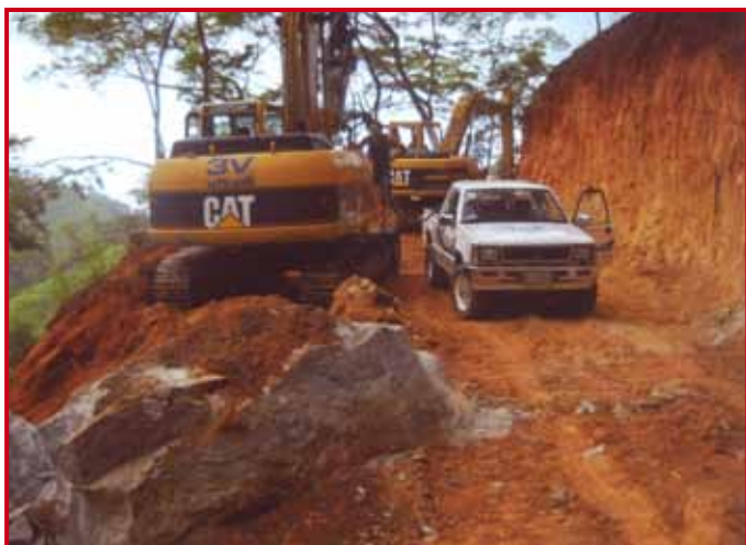
Lavori di scavo per la centrale idroelettrica
