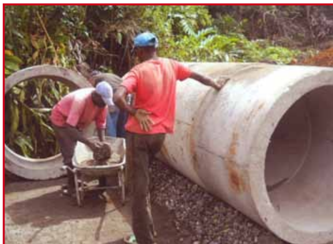
Attraversamento palude con tubi di drenaggio
