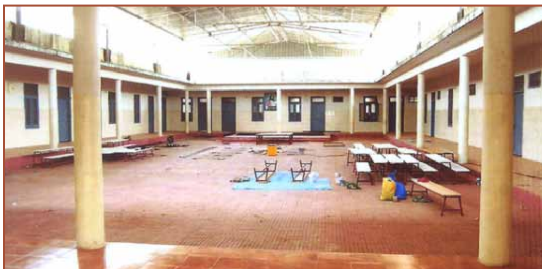
Per ampliare gli spazi è stata realizzata la copertura del cortile interno
